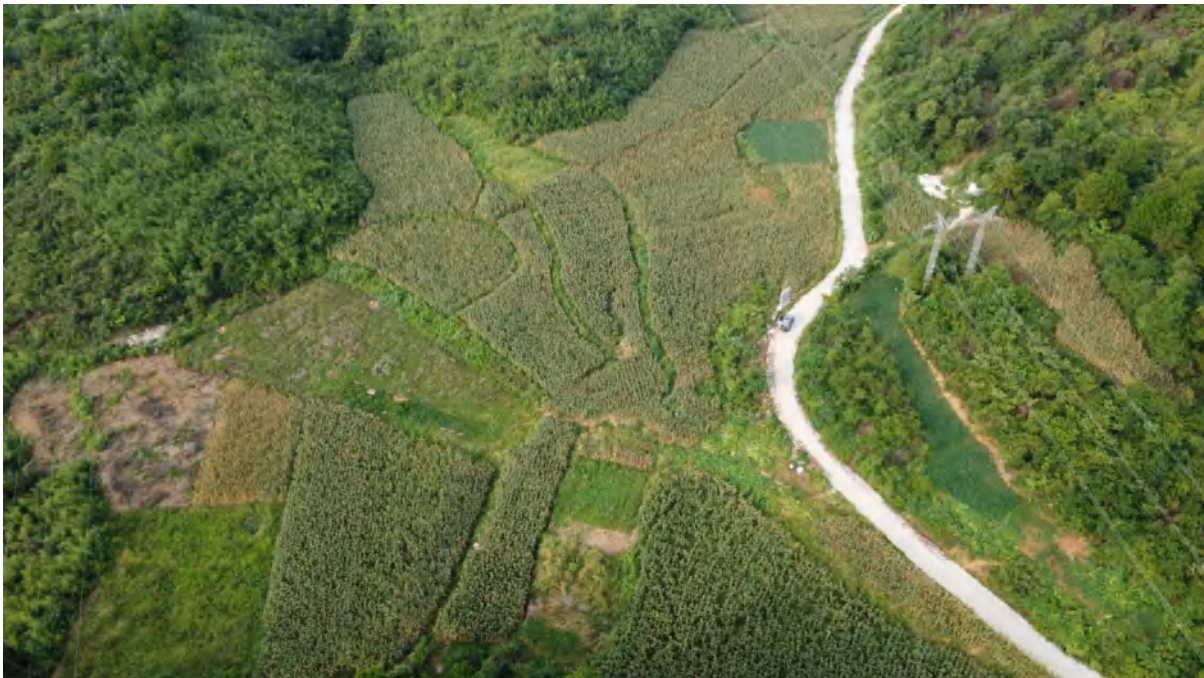
图 7.2-6 换流站航拍图
