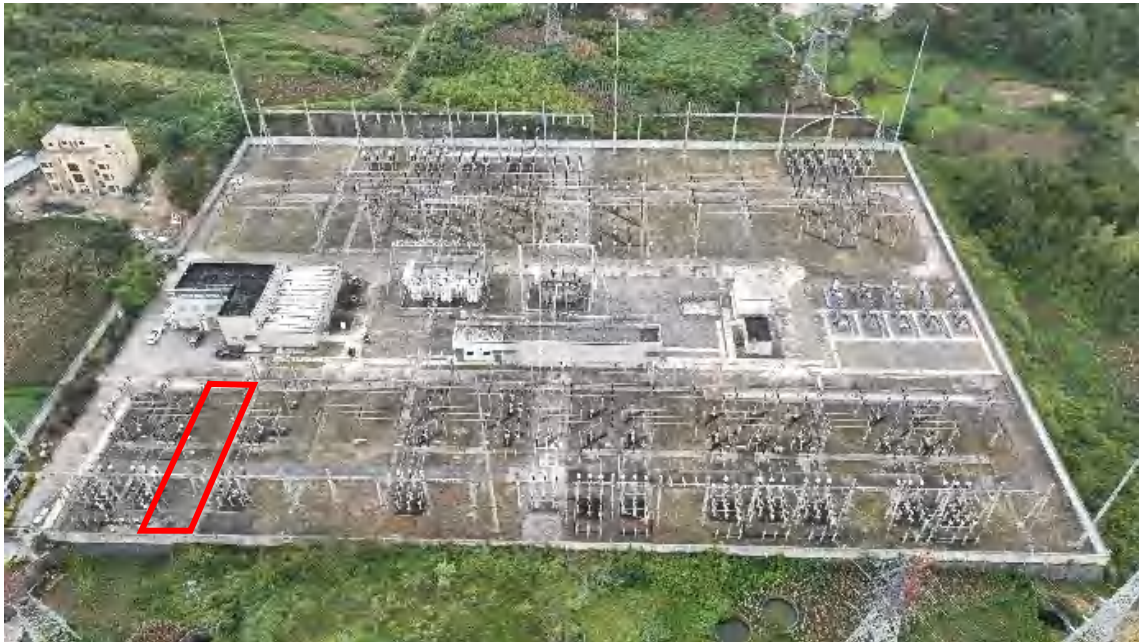
图 3.1-4 开天 220kV 变电站俯瞰图
