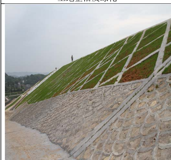
飞行区 浆砌石护脚及植草框格护坡
