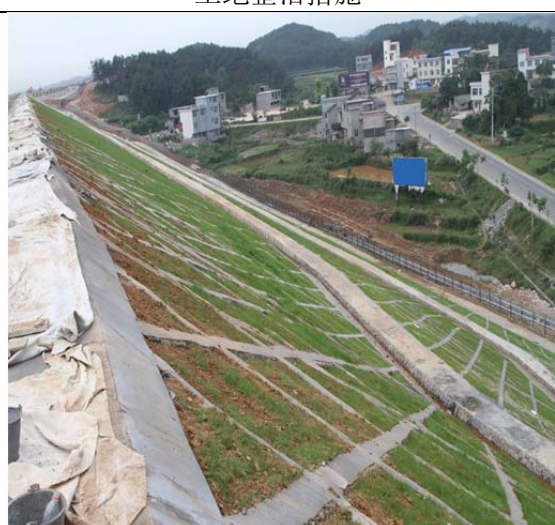
飞行区 浆砌石护脚及植草框格护坡
